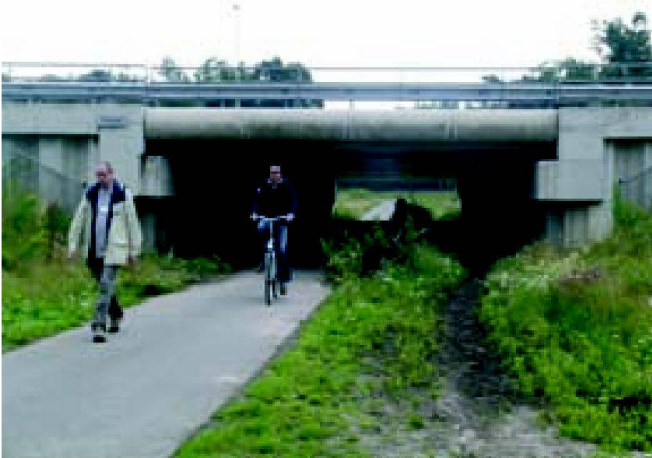
Abb. 1: Die Passage «Zevenbergen» bei Nistelrode in Holland. Die alte Unterführung für Fussgänger und Fahrräder wurde mit Wildstreifen auf beiden Seiten des Weges ökologisch aufgewertet.
