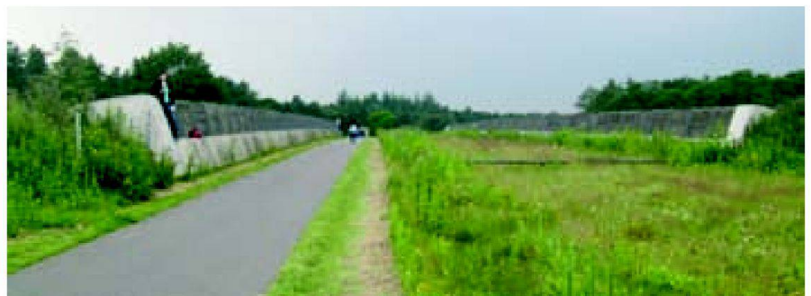
Abb. 3: Die Brücke «Slabroek» bei Uden in Holland. Die alte Autobrücke wurde durch eine gemischte Passage für Tier und Mensch ersetzt. Links im Bild ist der asphaltierte Streifen für Fahrräder und Spaziergänger, rechts der Wildstreifen. Die Holzstangen sind Barrieren gegen Menschen, die den Wildstreifen als Mountainbike-Strecke betrachten.
