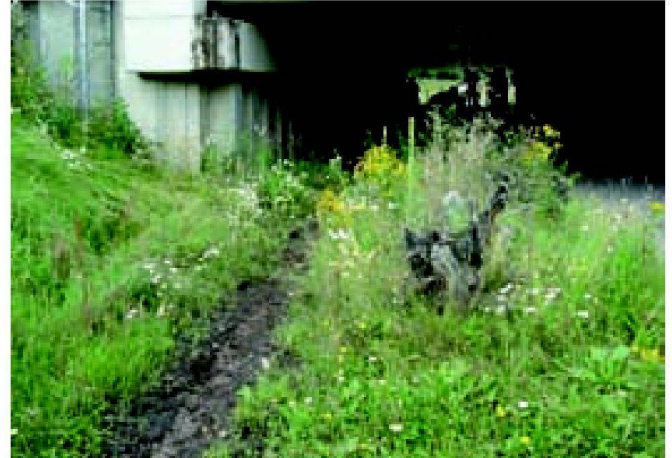
Abb. 2: Der Wildstreifen des Viadukts «Zevenbergen» wurde mit Wurzelstöcken (vorne rechts im Bild) besetzt, die Kleintieren wie Amphibien und Reptilien Schutz bieten und durch die Passage führen.
