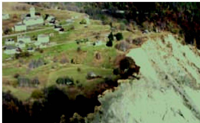
Abb. 10: Stabilisierte Rutschmasse im Valle di Campo TI.
