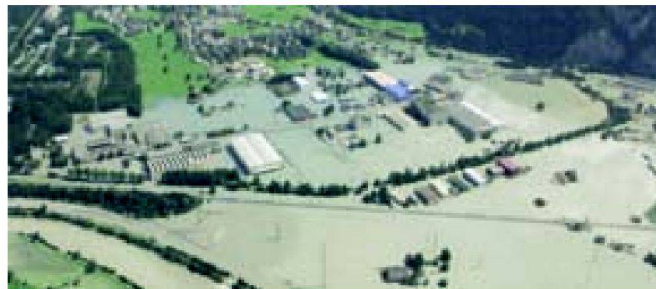
Abb. 7: Im August 2005 war die Industriezone in der Reuss ebene bei Schattdorf UR tagelang überschwemmt. Die Wehrdienste mussten grosse Mengen an verseuchtem Schlamm abpumpen.
