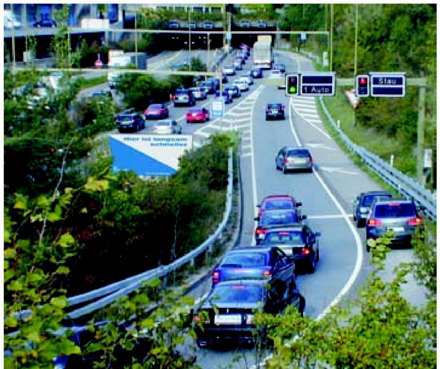
Abb. 2: Beispiel der intelligenten Strassennutzung: Damit der Verkehr auf der Autobahn nicht zusammenbricht, wird jener auf der Einfahrt dosiert (A20 Weiningen. Quelle: Tiefbauamt Kanton Zürich, Planung + Steuerung).
