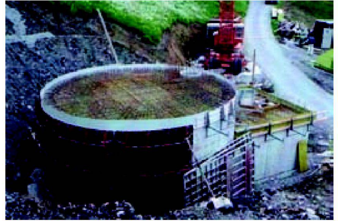
Abb. 3: Reservoir Innerthal SZ: gute Zufahrt, klares Baukonzept, einfacher Unterhalt.
