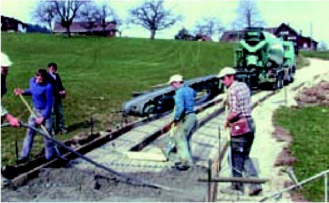
Abb. 6: Spurwegebau in Mosnang SG.
