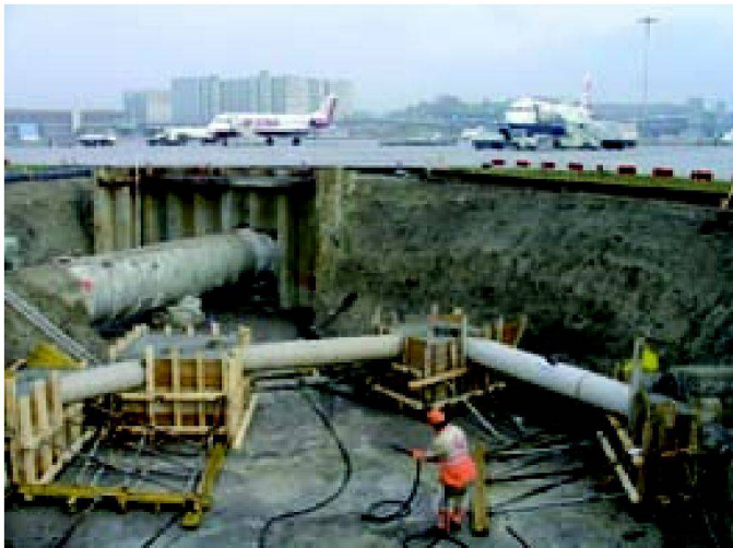
Abb. 2: Werkleitungsbau Abwasser. © Unique (Flughafen Zürich AG), 2009.
