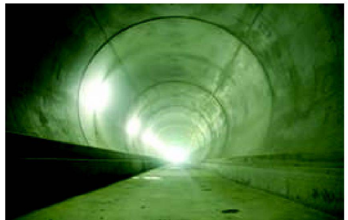
Abb. 9: Fertiger, ausbetonierter Tunnel.
