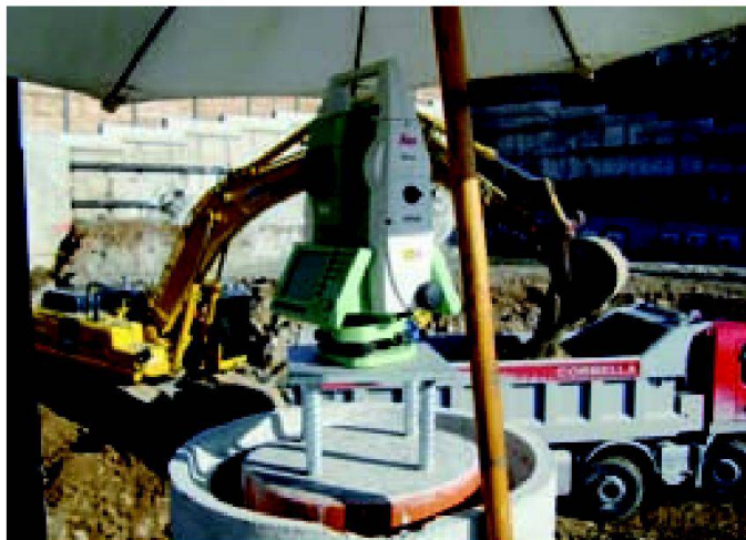
Fig. 5: Monitoraggio sui cantieri. Abb. 5: Überwachung auf den Baustellen.
