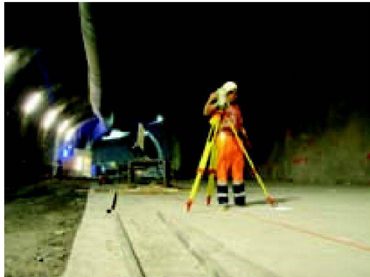
Fig. 2: Tracciamento in galleria. Abb. 2: Absteckung im Tunnel.
