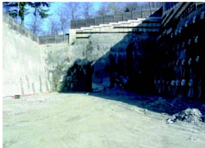
Fig. 6: La trincea di Vezia. Abb. 6: Voreinschnitt Vezia.
