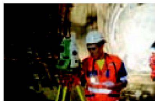
Leica Geosystems Präzisionstachymeter im Einsatz im Gotthard-Tunnel. Copyright Bilder: BSF Swissphoto AG.
