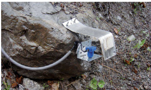
Abb. 2: Da ein Geophon kleinste Erschütterungen wahrnimmt, muss es mit einem kleinen Dach gegen Regentropfen geschützt werden.
