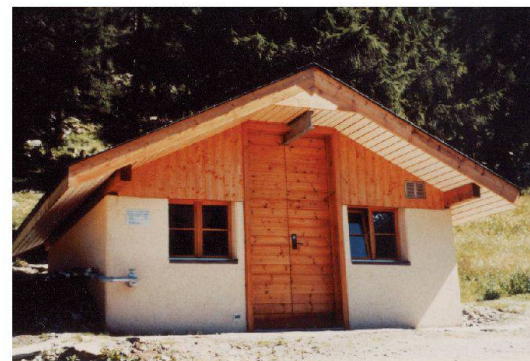
Abb. 7: Reservoir und Turbinenhaus Charal.
