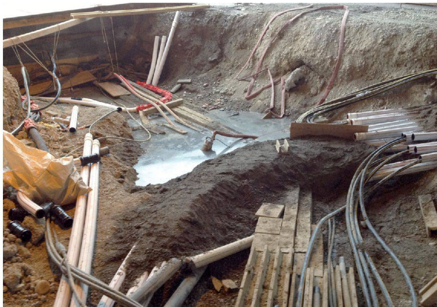
Abb. 1: Werkleitungsumlegungen beim Ausbau des Bahnhofs Oerlikon (Foto: Andreas Flury).
