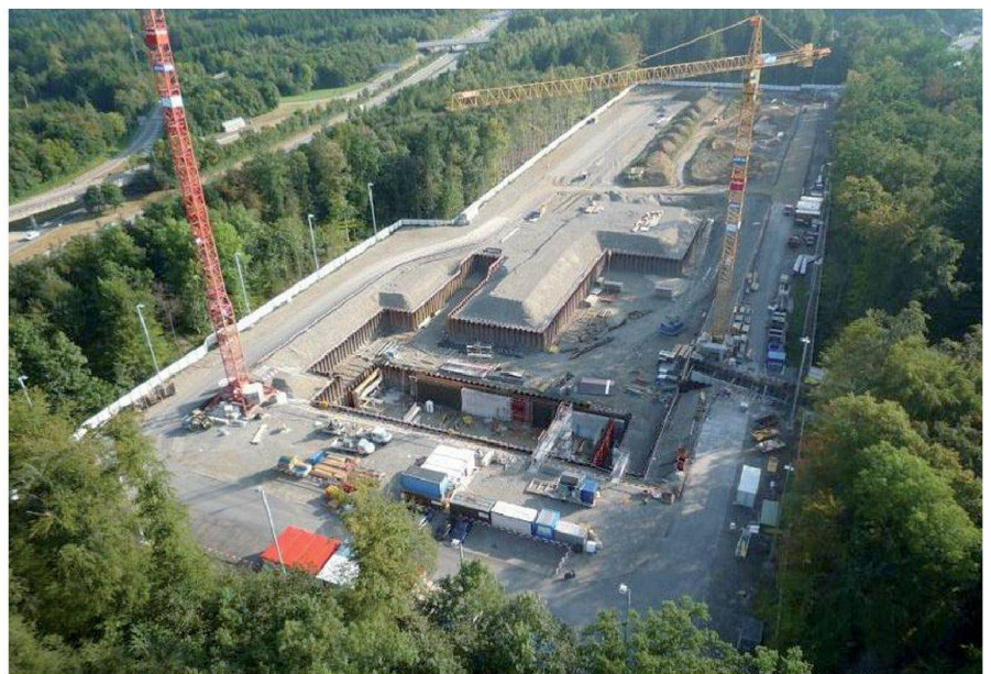
Abb. 2: Blick in die Baugrube, gut sichtbar die umfangreichen Spundwände.
