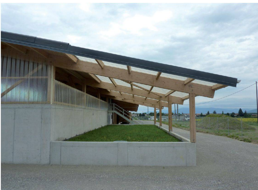
Fig. 2: Installation pour la biodégradation des matières actives.
