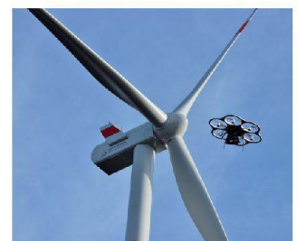
Abb. 3: Inspektion einer Windkraftanlage, Quelle Aibotix GmbH.
