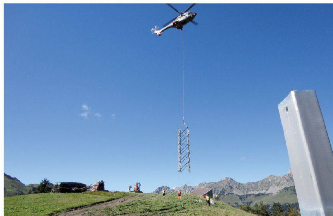
Fig. 4: Grand Clé – transport d'un élément du pylône P3.
