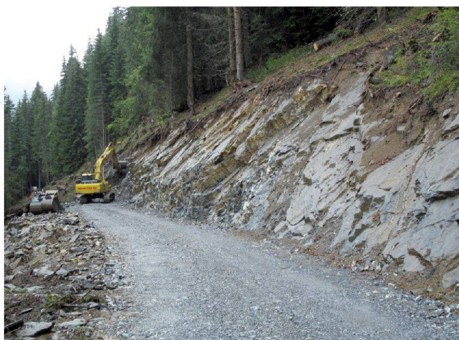
Abb. 6: Wegebau mit bergseitigem Felsabtrag (Sommer 2011).
