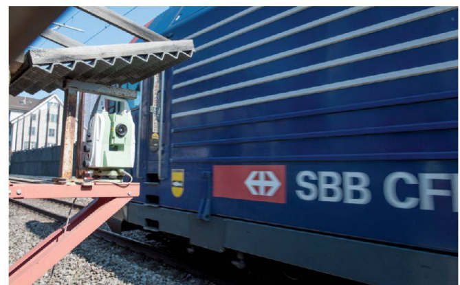
Abb. 2: Ein permanentes Gleismonitoring gewährleistet die notwendige Sicherheit im laufenden Baustellenbetrieb. Kostspielige Sperrungen der Gleise erübrigen sich.
