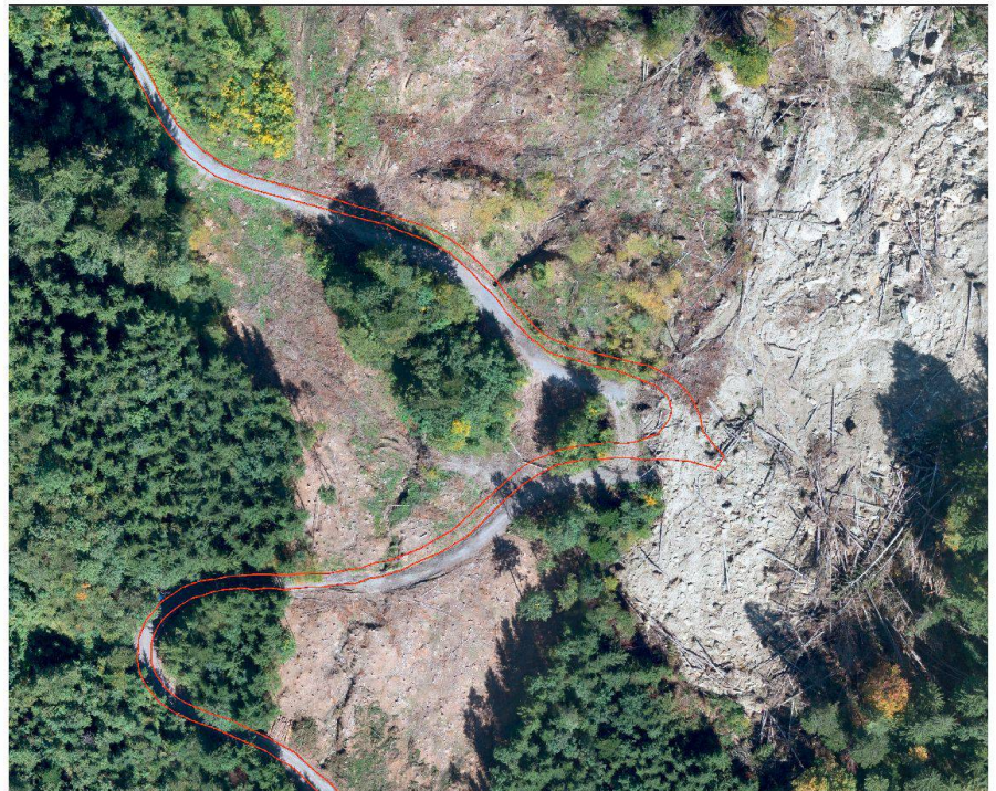
Abb. 7: Veränderung an der Howaldstrasse: Die Strasse wurde im Einflussbereich der Rutschung seit Rutschungsabgang bis maximal 6m talwärts verschoben; ein Grossteil dieser Bewegungen geschah im Laufe der Folgerutschung (Bild: Ingenieure Bart AG).
