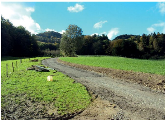
Abb. 9: Einbau von Asphaltgranulat als Strassenkoffer nur in Ausnahmen und unter genau definierten Rahmenbedingungen.
