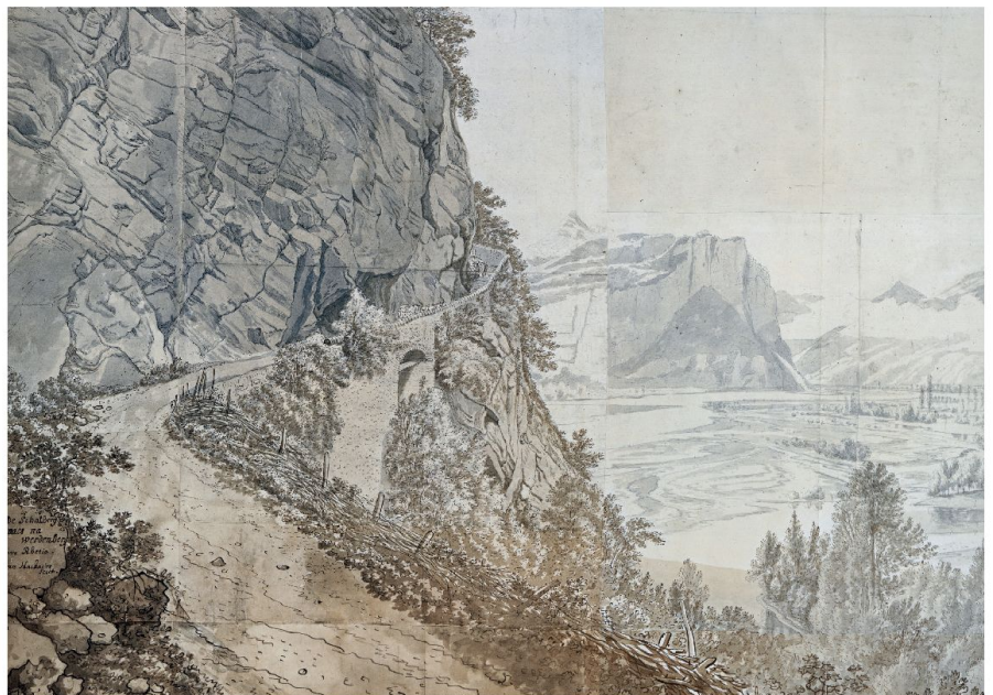
Abb. 4: Jan Hackaerts bekannte Zeichnung der Hohwand ist die älteste bildliche Darstellung der Schollbergstrasse. Sie zeigt exemplarisch die unterschiedlichen Elemente des Ausbaus mit Halbgalerie, Brücke, Stützmauer, Brüstungsmauer oder Flechtzaun, erdiger Fahrbahn im Flachen und Pflasterung auf der Gefällsstrecke (Ausschnitt nach: JAN HACKAERT, Die Schweizer Ansichten, 1653-1656, bearb. und kommentiert von Gustav Solar. Dietikon-Zürich 1981, Tf. 14).
