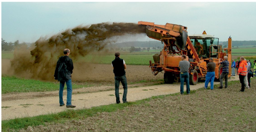
Abb. 4: Bankettfräse im Einsatz (Bild: W. Wehrli).
