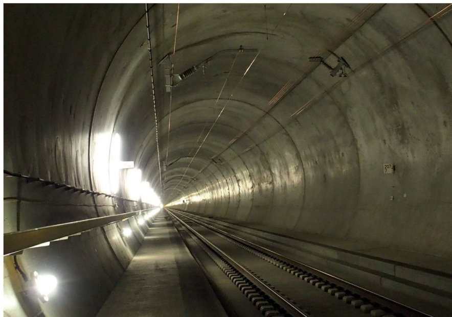
Abb. 3: Blick in die Weströhre.
