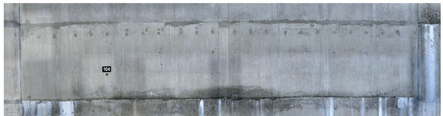
Fig. 8: Résultat d'une ortho-photo, composée d'une trentaine d'images.
