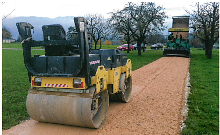
Abb. 3: Neubau eines Weges in der Gesamtmelioration Blauen.
