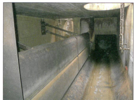
Abb. 2: Hochwasserentlastung in San Nazzaro (Sciarini SA).
