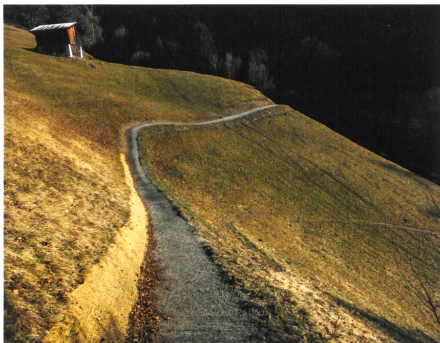
Abb. 3: Ausgebesserter Wanderweg mit teilweise neuer Linienführung.
