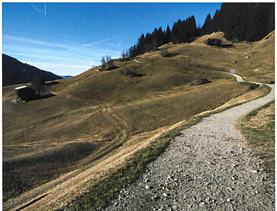
Abb. 2: Klosters-Serneus: Neue Linienführung der durch die Landwirtschaft und den Langsamverkehr gemeinsam genutzten Kiesstrasse.
