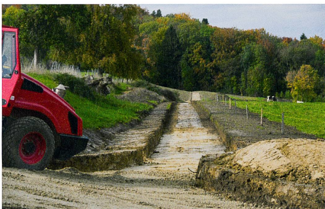
Abb. 4: Der Flurstrassenneubau konnte gegenüber dem Vorprojekt massiv reduziert werden.
