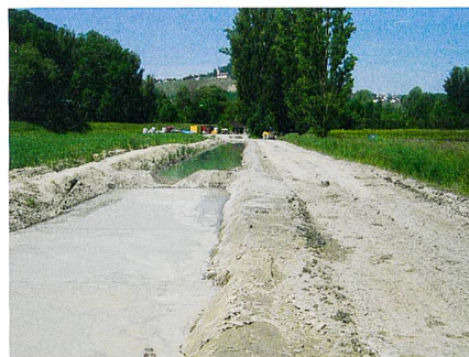
Abb. 11: Absetzbecken im Grabenstrassee.
