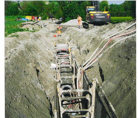
Abb. 13: Neue Hauptleitung zum Entwässerungspumpwerk in 4 m Tiefe.
