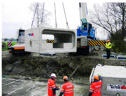
Abb. 5 und 6: Brückenersatz mit vorgefertigten Elementen.
