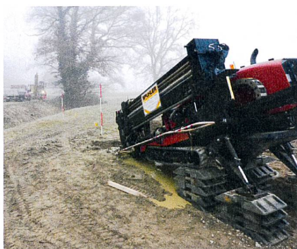
Abb. 16: Spülbohrung unter Holenrütigraben (öffentliches Gewässer).
