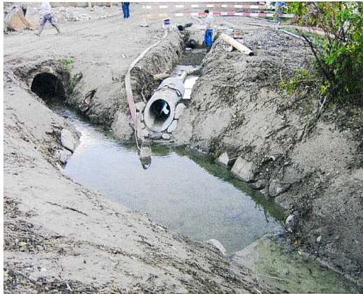
Abb. 9: Auslaufbauwerk des neuen Entwässerungspumpwerkes.
