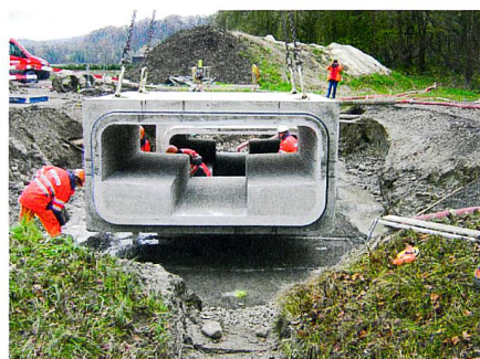
Abb. 5 und 6: Brückenersatz mit vorgefertigten Elementen.
