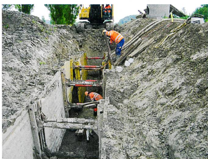
Abb. 10: Neue Hauptleitung zum Entwässerungspumpwerk in 4 m Tiefe.
