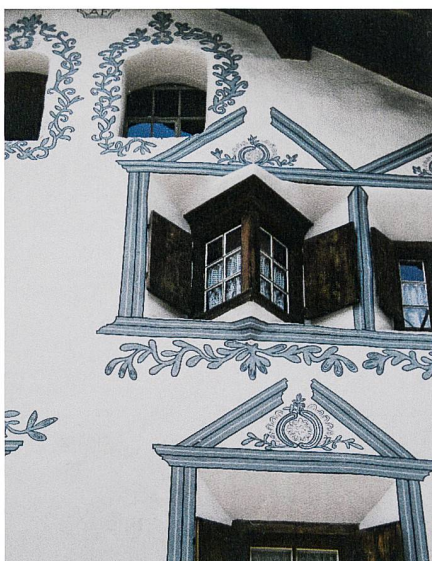
Abb. 2: Bergün: Detail einer Fassade.
