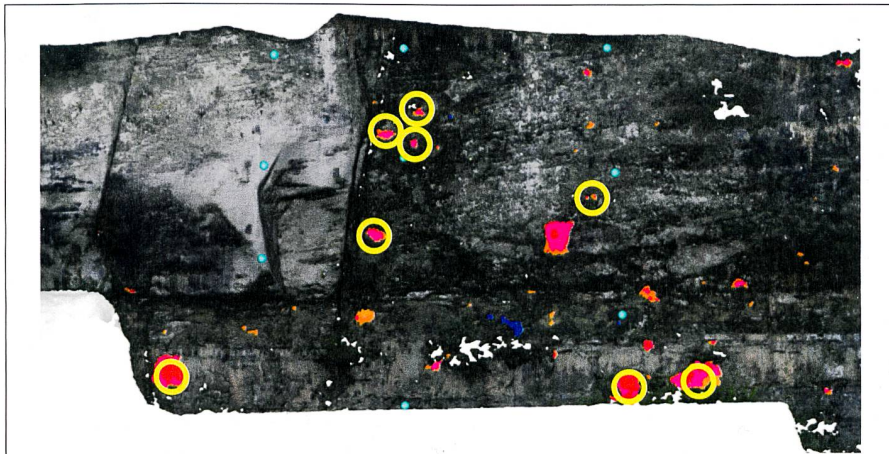
Fig. 6: Inspection E1 – E2 (cercles jaunes = décrochements).
