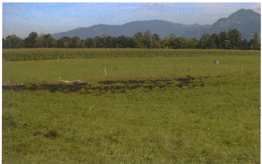
Abb. 2: Marbacher Isenriet vor Umsetzung des Projekts. Das Ausmass der Setzung ist am Schacht ersichtlich.
