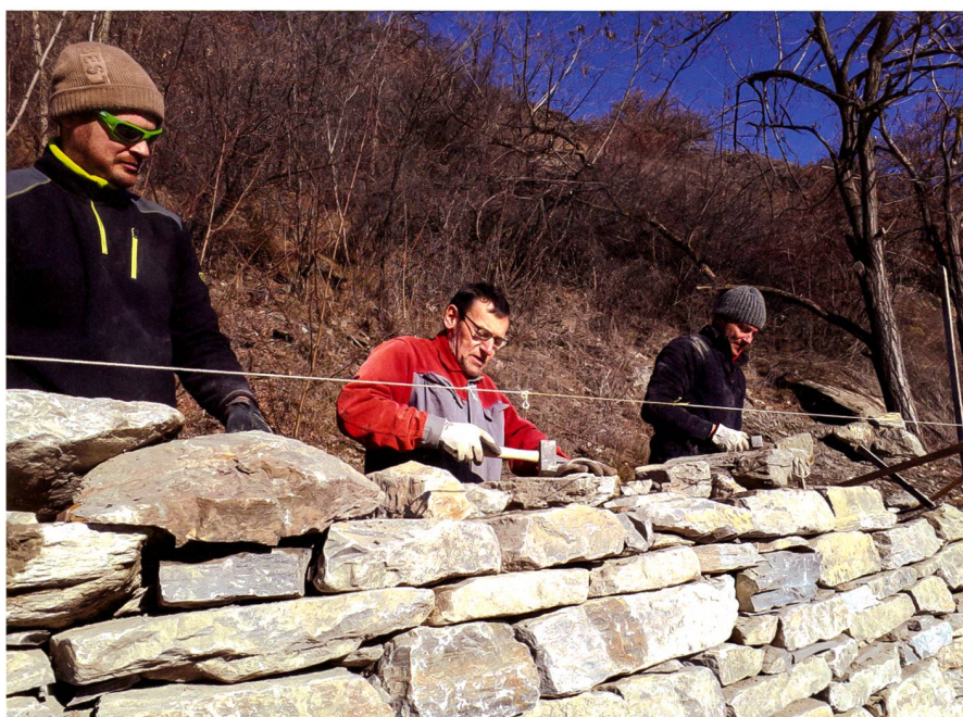
Fig. 5: Cours de formation à Châteauneuf. Martin Lutz enseigne sur le terrain les bons gestes pour construire un mur.
