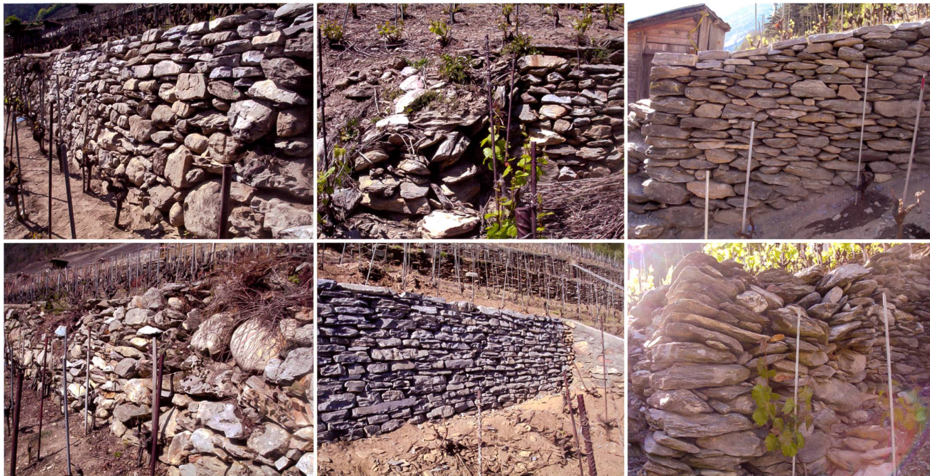
Fig. 3: Exemples de réalisation (après et avant travaux).
