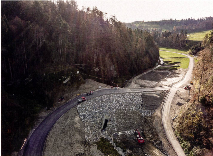
Abb. 2: Sicht auf die Talseite des Hochwasserschutzdamms und den Einstaubereich im oberen Teil des Fotos.
