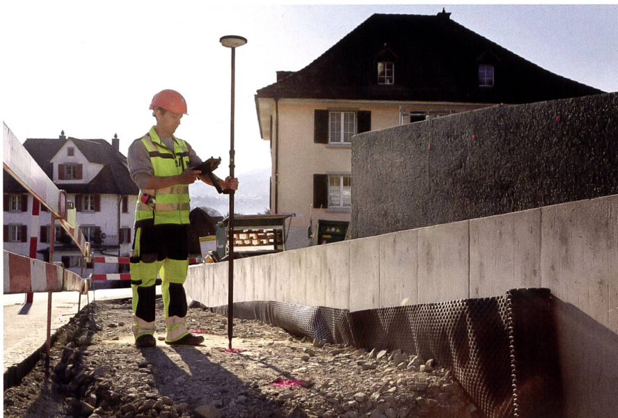
Vereinfachte Leitungsvermessung im Kanton Zürich dank der Kopplung der Leica GG04 plus mit dem mobilen GIS-Werkplan.
