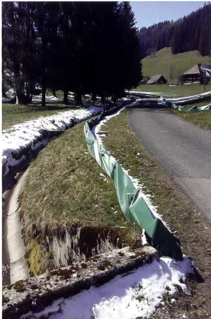
Abb. 3: Zuleitstruktur für Amphibien im Gummental, Trub (Foto: Karin Zürcher).
