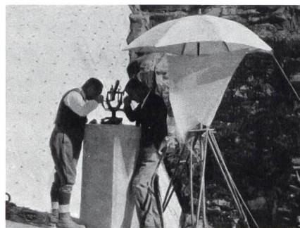
Fig. 2: observation avec un théodolite Hildebrand à un axe, réseau de «Barberine» (Lang 1929).
