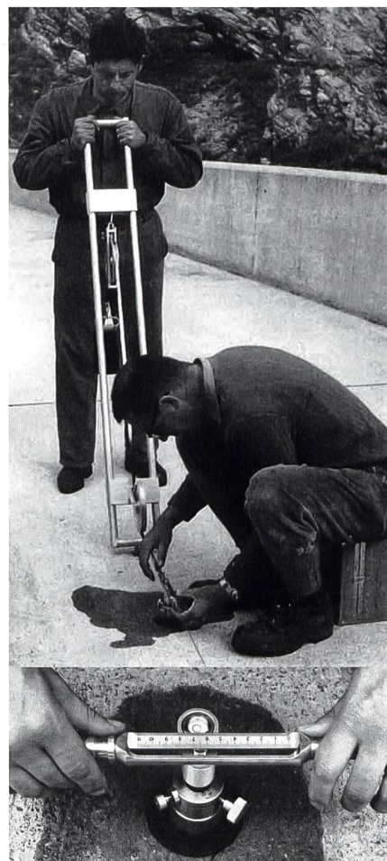
Abb. 6: Distanzmessung mit Invarband/-draht; Spannbock und Ablesemasstab für Polygonmessung auf der Staumauer «Malvaglia» (Kern Bulletin 7, 1963).
