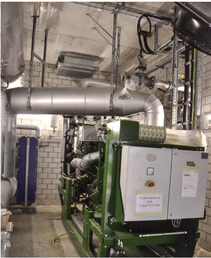
Abb. 2: Der Motor verbrennt das Prozessgas und treibt damit den Stromgenerator an. Die Prozesswärme wird zur Schnitzeltrocknung und zur Gebäudeheizung verwendet. Der Motor steht, damit seine Vibrationen nicht in Umgebungslärm umgewandelt werden, auf Gummiplatten.
