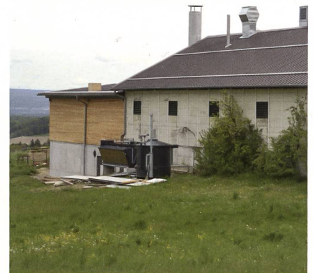
Abb. 1: Ein Teil des Holzkraftwerkes ist in das bestehende Ökonomiegebäude integriert. Dadurch konnte das Bauvolumen und die benötigte Landfläche gering gehalten werden.
