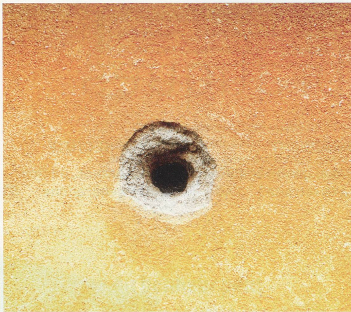
Les trous peuvent être rangés dans la catégorie usure normale dans la mesure où ils ont été rebouchés.
