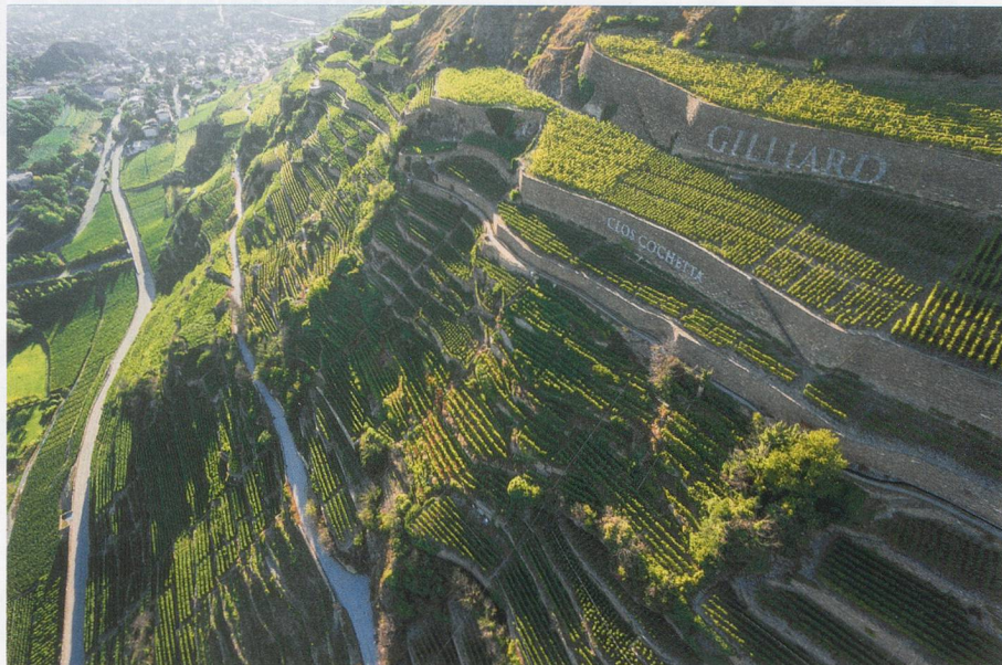
Le plus grand mur en pierres sèches du monde!
