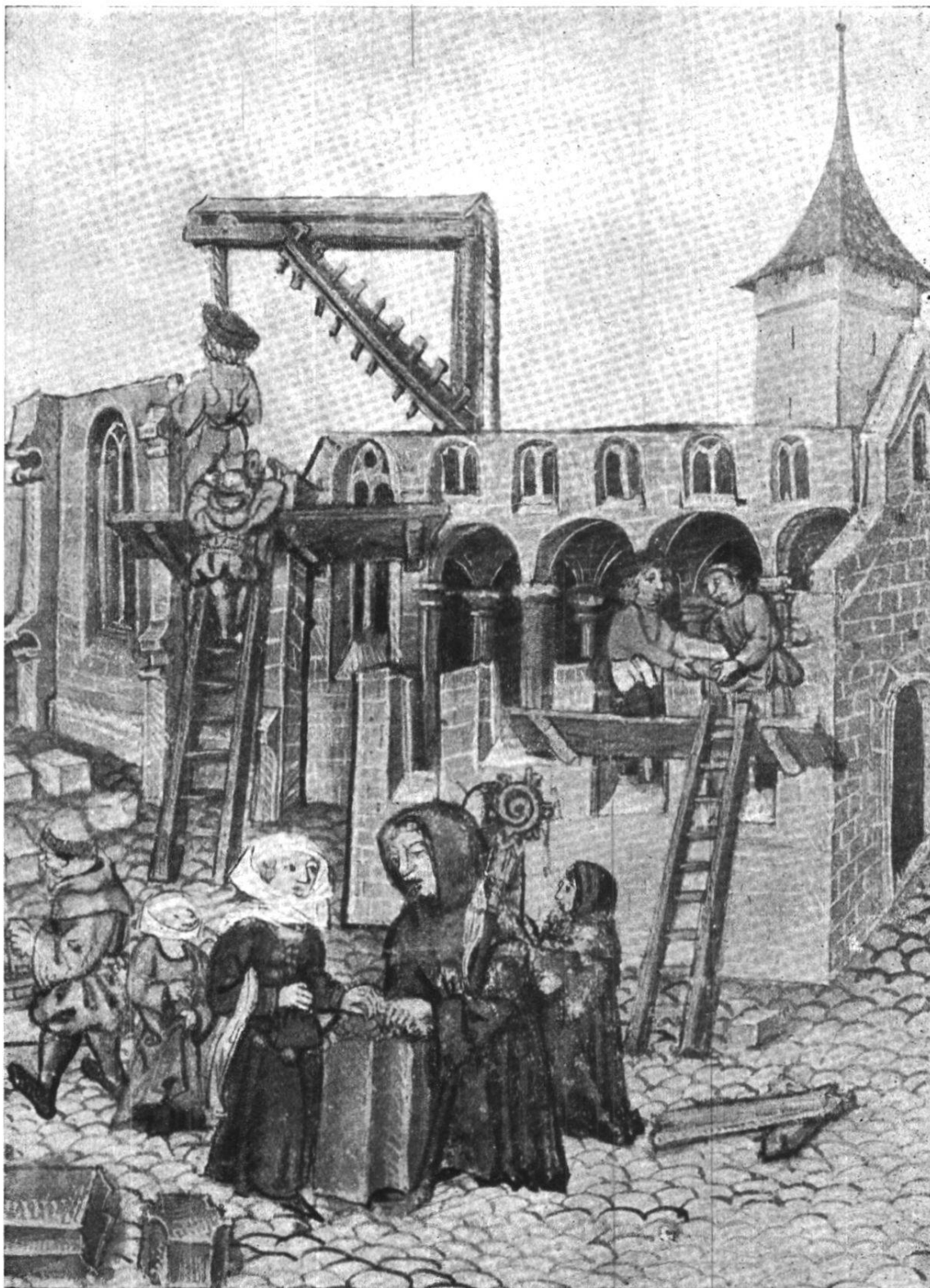
Der Bau der Barfüßerkirche und die Stifterin Guta von Rothenburg (Nach Dieb. Schillings Chronik)
