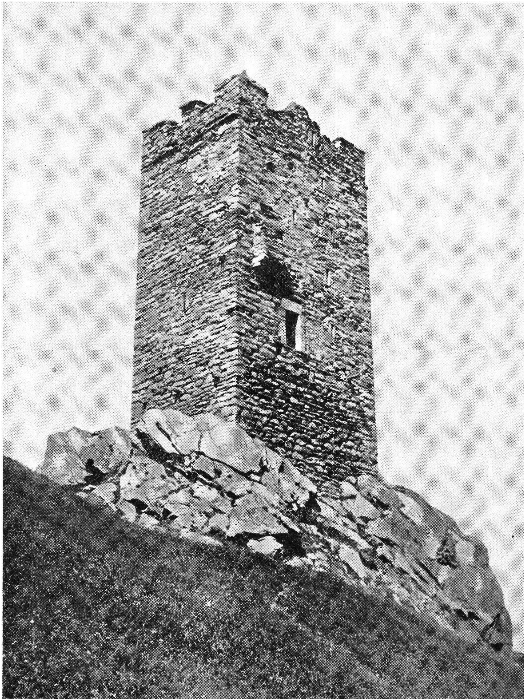
Die Burg zu Hospenthal Ansicht von Süden, aufgenommen um 1895 Vor der Restauration
