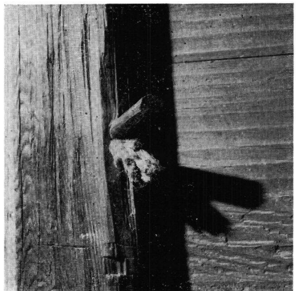
Abb. 7 Zell-Hüs wil Hanfverpflöckung am Türpfosten zu einer Schlafkammer im Obergeschoß
