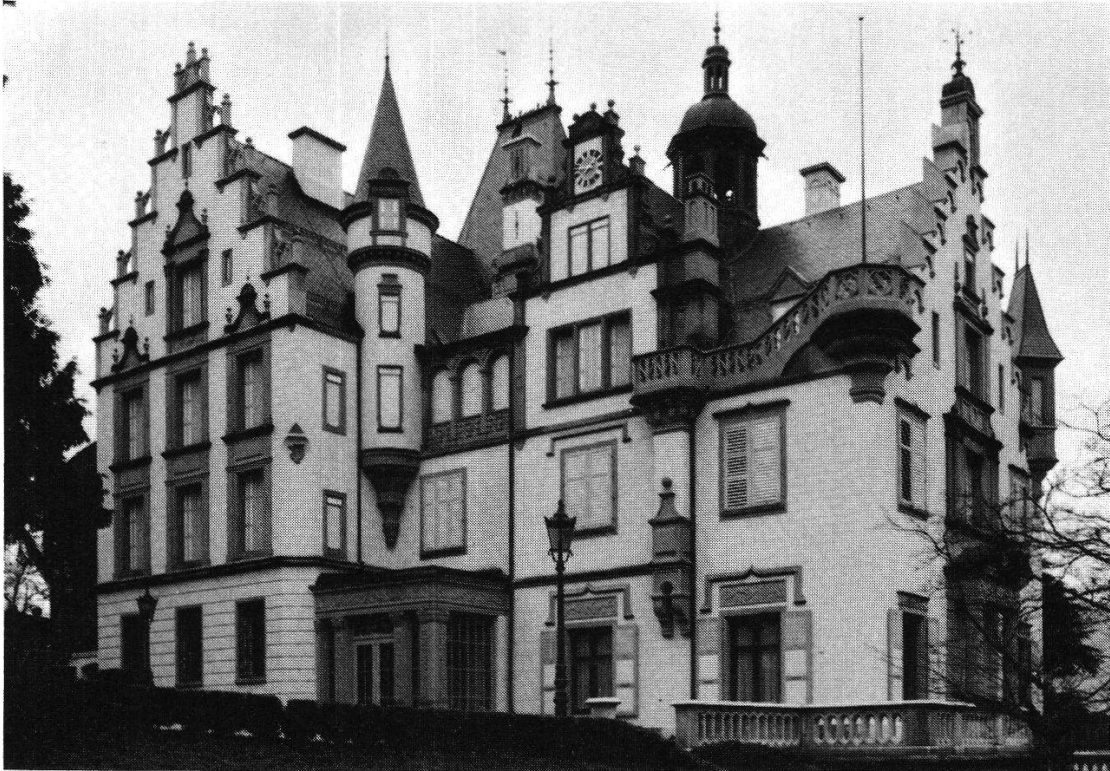
Schloss Meggenhorn von Norden. Heutiger Zustand.
