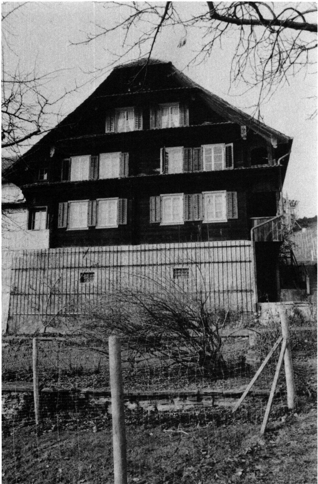
Das Bauernhaus Meggenhorn (erb. zw. 1700 und 1735) vor der Renovation.
