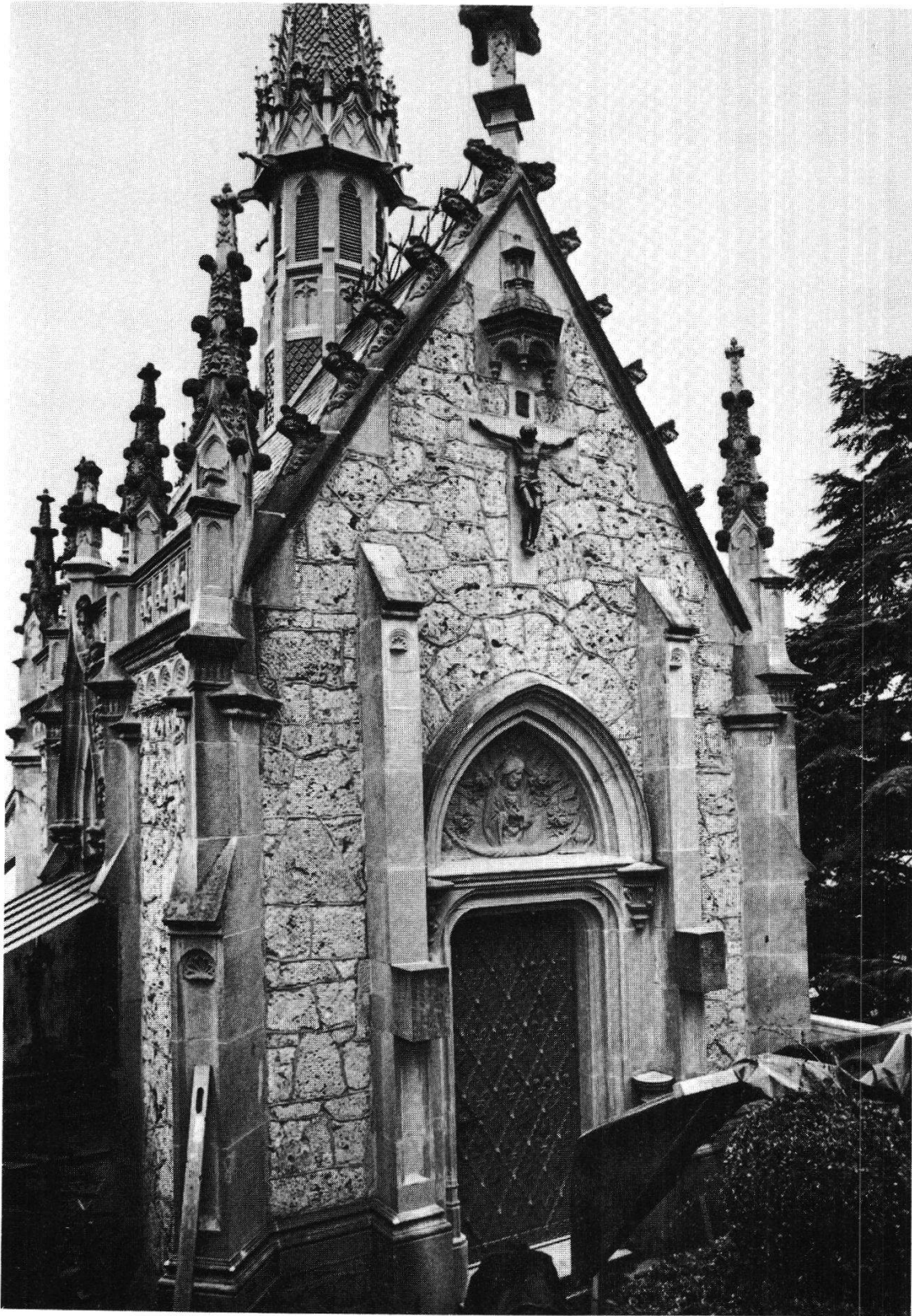
Kapelle Meggenhorn, Nordfassade.
