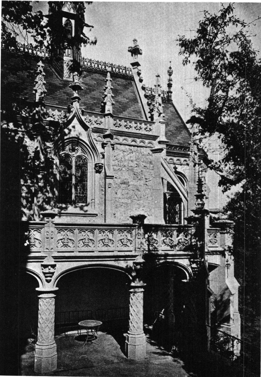
Kapelle Meggenhorn, Westfassade. Nach einer alten Photographie.
