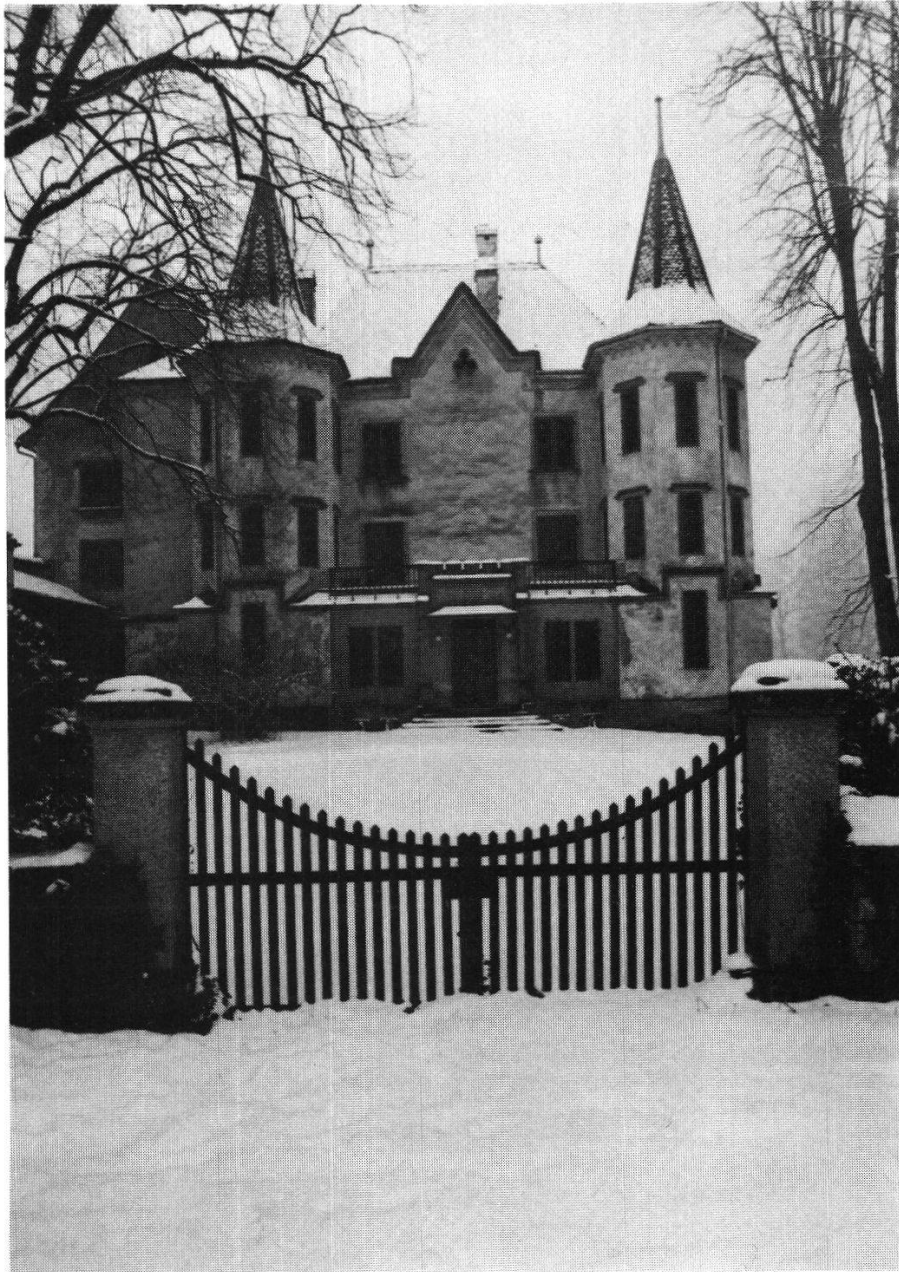
In den Formen der dogmatischen Neugotik wurde 1846 Schloss Amsoldingen von Gottlieb Hebler umgebaut.
