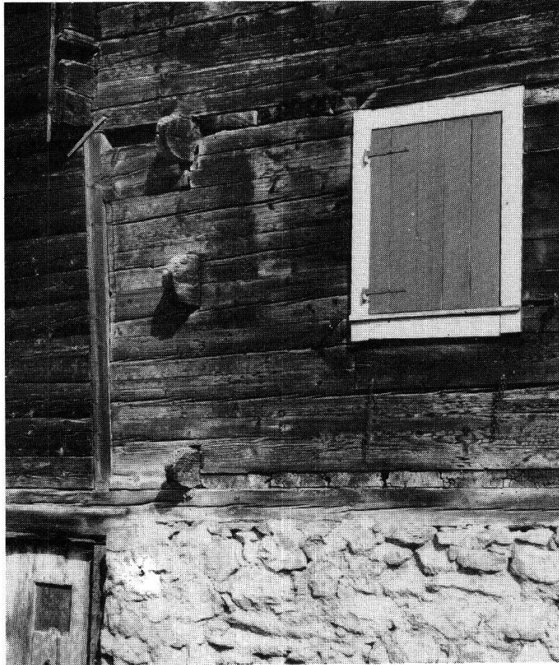
Abb. 3: Fassadenbündige Bodenbohlen und unregelmässige Einzelvor- stösse (Morschach, Tannen, 1317/ 41).
