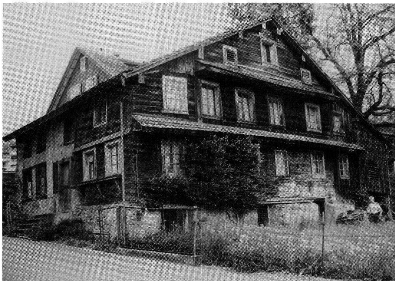
Abb. 18: Steinen, Kreuzstrasse 8, Acher, 1313/38: Ansicht von Südwe- sten.
