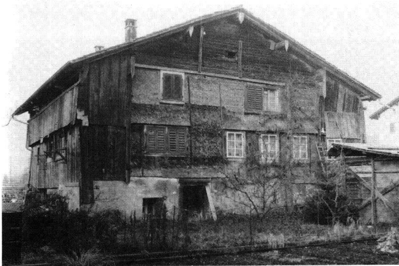
Abb. 16: Schwyz, Hinter Ibach, 1318/42: Ansicht von Südwesten.
