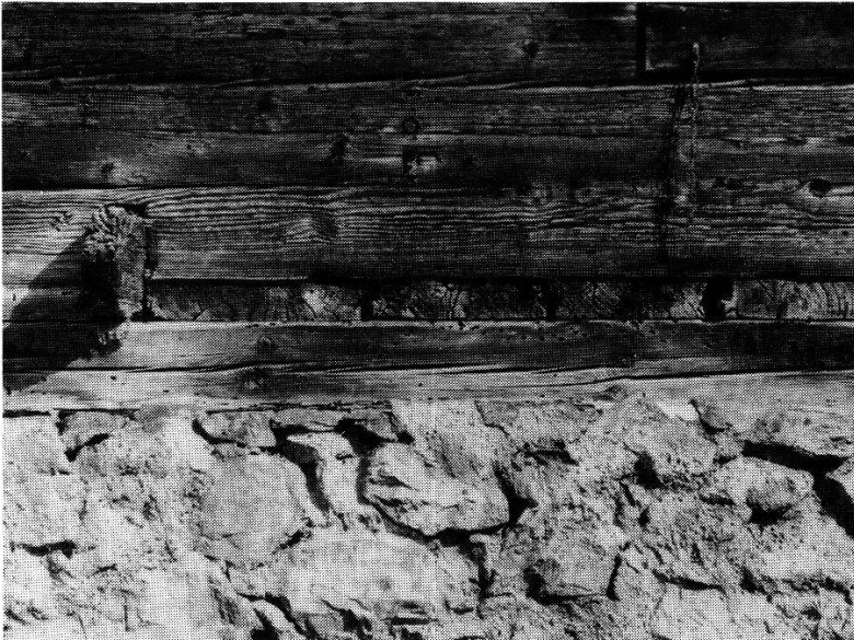
Abb. 1: Fassadenbündige Bodenbohlen (Morschach, Tannen, 1317/41).
