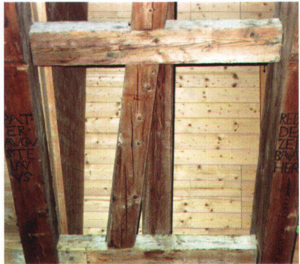
Abb. 10: Detail des 1690 errichteten Dachstuhls im Herrenhaus Grafenort. Foto: Michael Tomaschett, Zürich.
