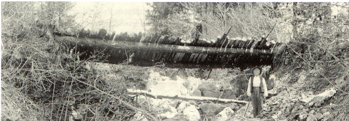
Abb. 5: Die Würzlibrücke auf dem Weg von Schwyz in Richtung Haggeneegg. Die Fotografie aus dem Jahre 1892 von Josef Bettschart (1843–1900) vermittelt einen guten Einblick in den Bau von Brücken und Stegen in vergangenen Zeiten. Viele Konstruktionen waren einfach und hatten häufig auch kein Brückengeländer, wie dies etwa auch für die zwischen 1358 und 1360 erbaute Rapperswiler Brücke bezeugt ist (Staatsarchiv Schwyz, Fotosammlung).
