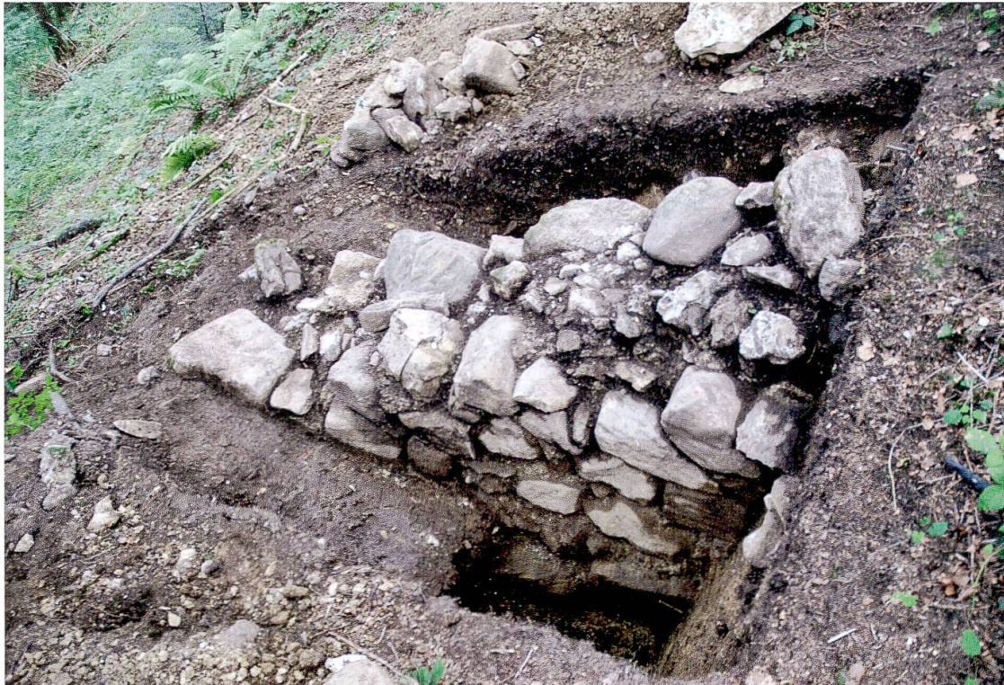
Abb. 5: Schnitt S2, freundseitige Front der Letzimauer mit gut erkennbarem Fundamentabsatz, von WNW.
