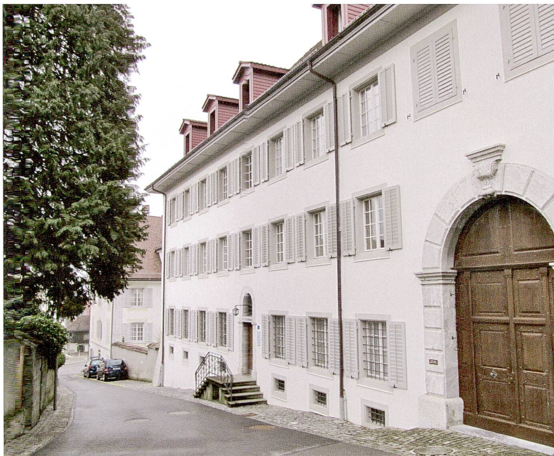
Der Klosteranbau von 1730 vom St.-Klara-Rain aus. Pestalozzi lebte im Erdgeschoss. (Foto: Urs Haller)
